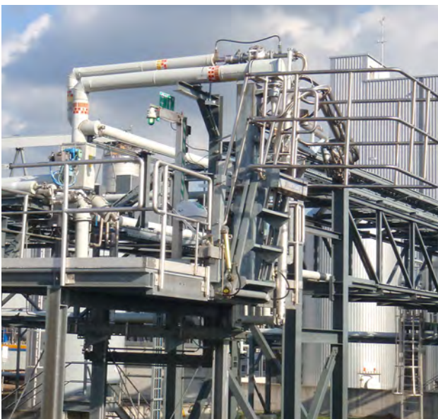
Tanknotdusche in Leitung eingeschliffen / Freier Auslauf DIN 1717
