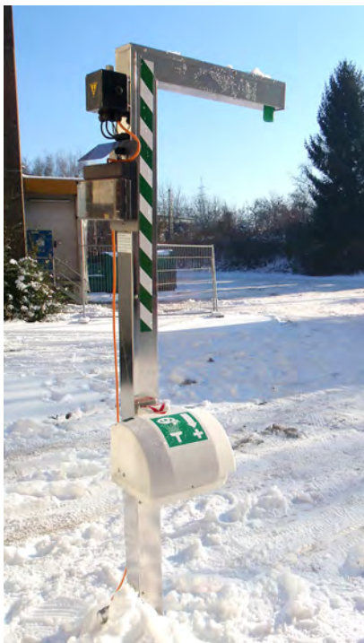
Notdusche im Winterbetrieb / Safety shower in wintertime
